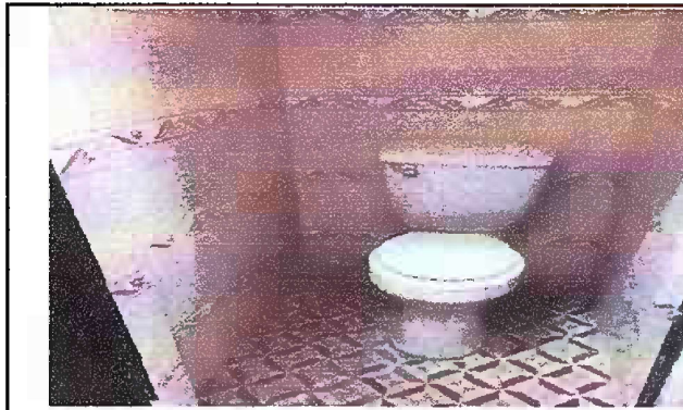
Foto 4: Sustitución de inodoro
