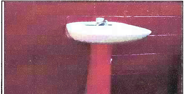
Foto 6: Sustitución de lavamano.
