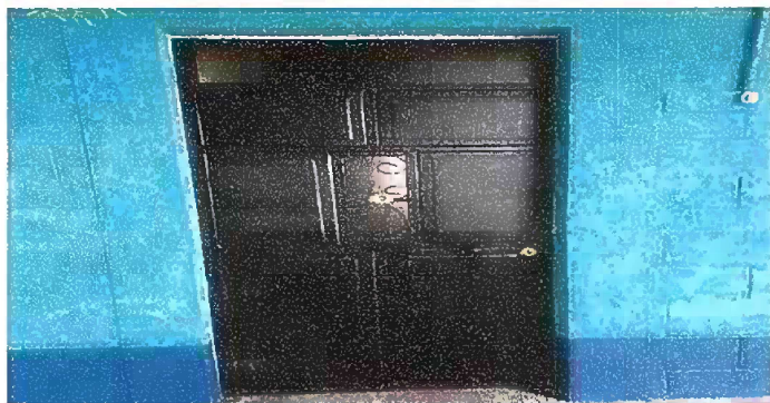
Foto 5: Modulo 1 Sustitución de puertas
