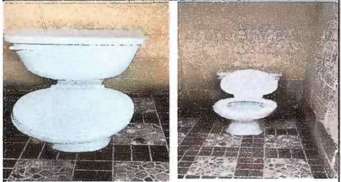
Foto 8. Módulo 3 Sustitucion de inodoro
