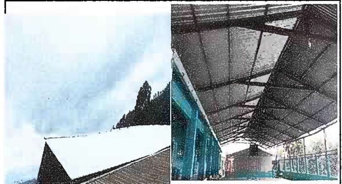
Foto 2: Sustitucion de laminas Troqueladas Aluzinc
