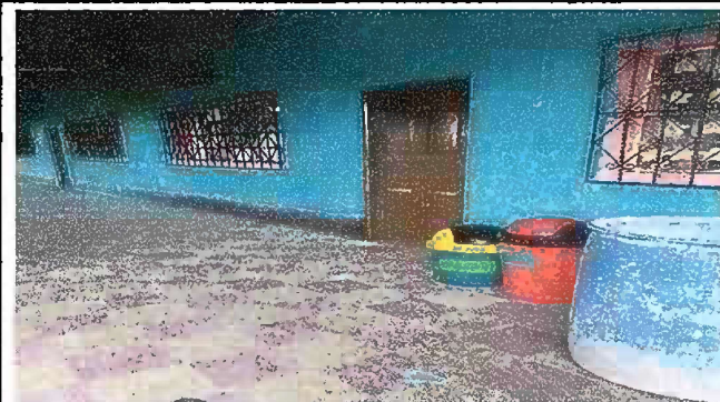
Foto 11: Modulo 5 Sustitución de pintura en muros exterior e interior
