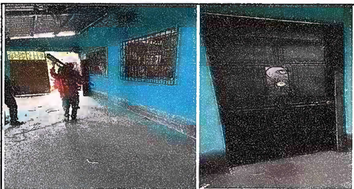
Foto 5: Modulo 1 Sustitución de puertas
