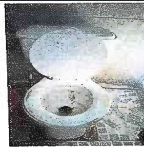
Foto 8. Módulo 3 Sustitucion de inodoro
