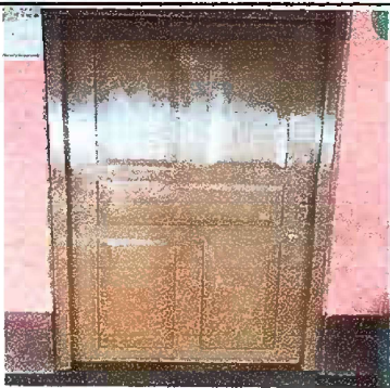
Foto 5: Modulo 1 Sustitución de puertas
