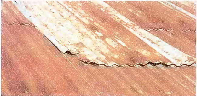
Foto 2 Sustitucion de laminas Troqueladas Aluzinc
