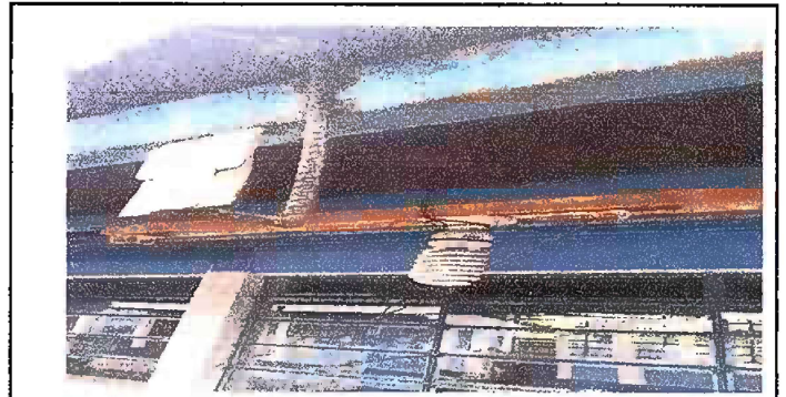
Foto 4: Sustitucion de plafoneras, cajas octagonales y bombillas
