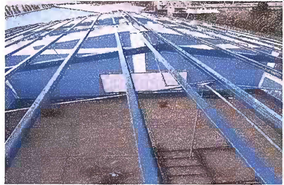
Foto2: Modulo 1. Mantenimiento de estructura de soporte de metal
