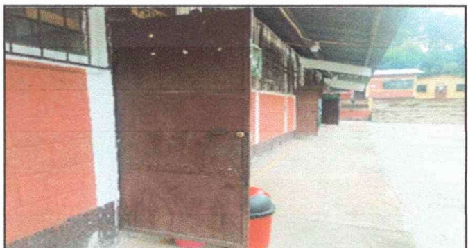
FOTO 6 MODULO 1: Sustitución de puertas de metal
