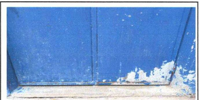
Foto 6: Modulo 5: Sustitución de puerta en servicios sanitarios
