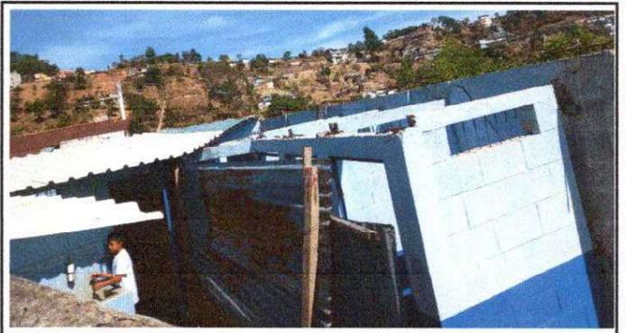
Foto 2: Modulo 5: Instalación de estructura portante de metal
