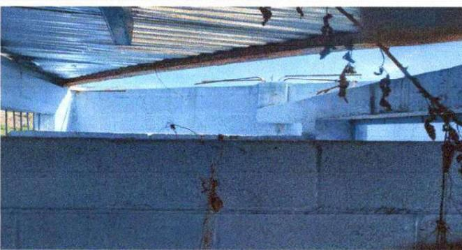
Foto 3: Modulo 5: Instalación de lamina por lamina troquelada aluzinc
