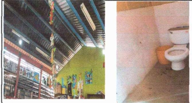
Foto 2: Módulo 2: Sustitución de focos ahorradores; Sustitución de inodoro y piso de torta de concreto
