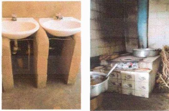
Foto 3: Módulo 2: sustitución de lavamanos y sustitución de plancha de 4 hornillas y pisos de azulejos.
