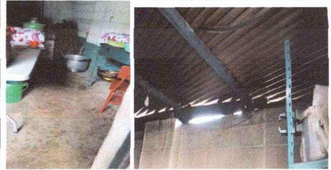
Foto 4: Módulo 2: Sustitución de piso de torta de concreto y sustitución de lamina, por lámina troquelada aluzinic calibre 26 y de soporte de madera, por metal.
