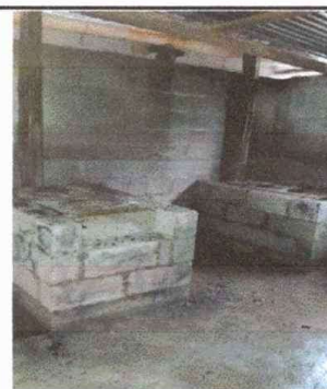
Foto 6: Modulo 2. Sustitución de plancha de metal de 3 hornillas.
