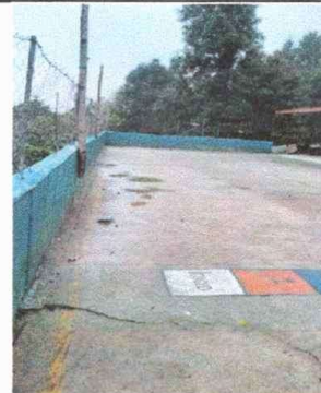
Foto 4: Muro perimetral. Reparación de muro perimetral de block con tubo hg y malla galvanizada, soleras intermedias y columnas.
