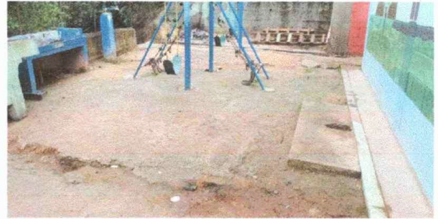
Foto 2: Cancha. Reparación de planchas de concreto de patio.
