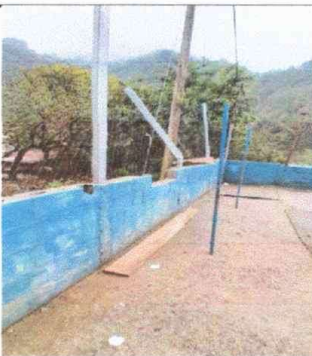
Foto 5: Muro perimetral. Reparación de muro perimetral de block con tubo hg y malla galvanizada, soleras intermedias y columnas.
