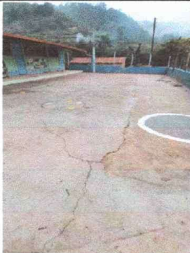
Foto 3: Cancha. Reparación de planchas de concreto de patio.
