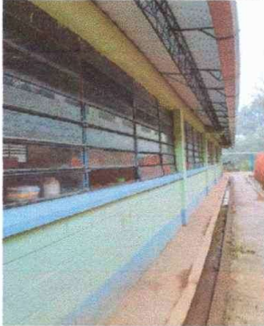
Foto1: Modulo 1. Suministro e instalación de balcones de hierro en ventana
