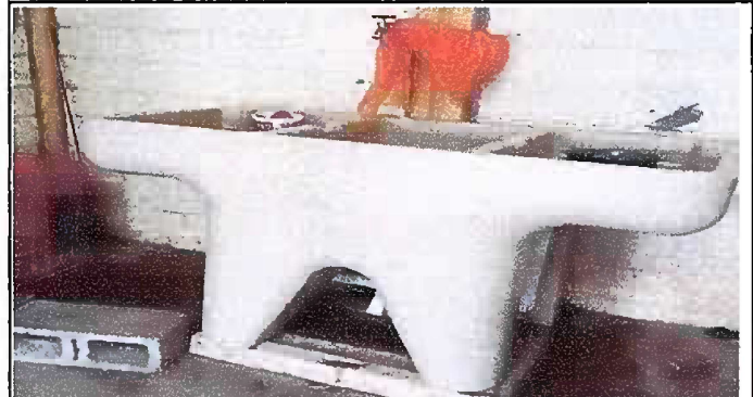
Foto 4: MODULO 3 Sustitucion de pilas de cemento de 2 lavaderos
