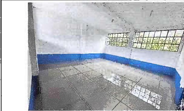
Foto 1: MODULO 1 Sustitucion de piso de torta de concreto por piso ceramico
