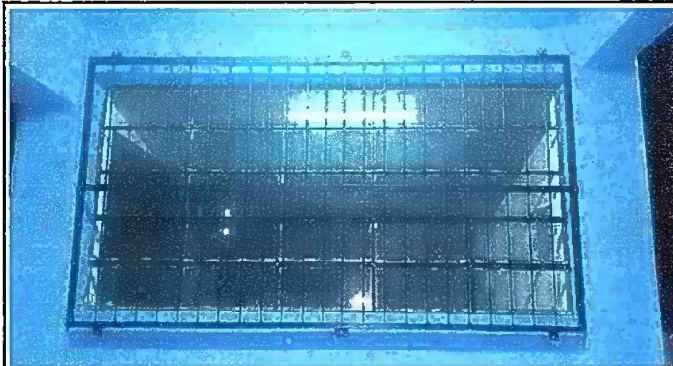
Foto 3: MODULO 2 Suministro e instalacion de balcones de metal
