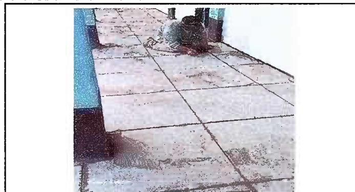
Foto1: MODULO 1 Sustinucion de piso de torta de concreto por piso ceramico
