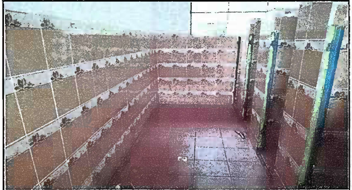
Foto 2 Servicios sanitarios: Suministro e instalación de azulejo.
