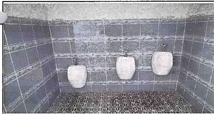
Foto 5 Servicios sanitarios : Sustitución de mingitorio
