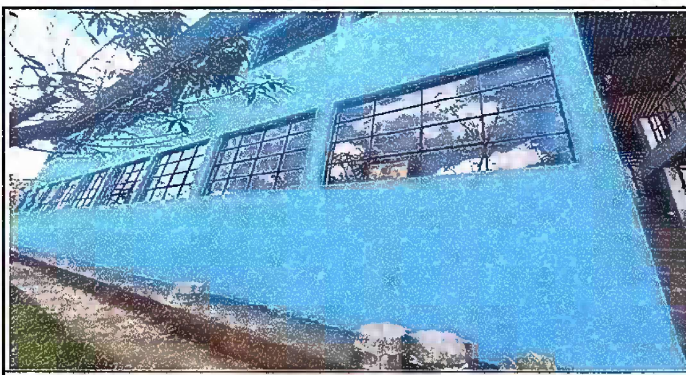
Foto 5, módulo 1: Pintura en muros exteriores e interiores
