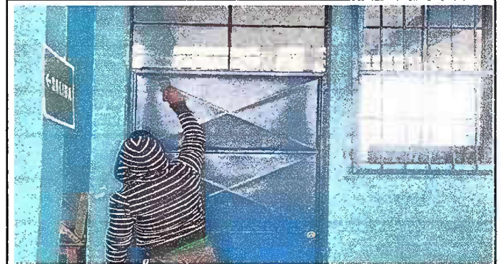
Foto 4, módulo 1: Mantenimiento a estructura de puerta (lijado, cepillado y aplicación de pintura)
