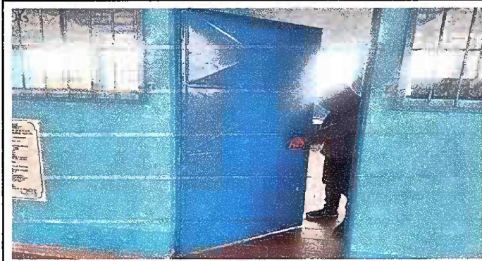
Foto 3, módulo 1: Sustitución de chapa
