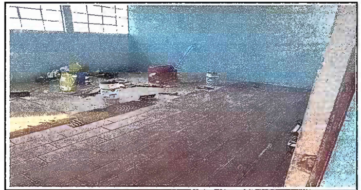
Foto 6, módulo 2: Sustitución de piso de concreto por piso cerámico.
