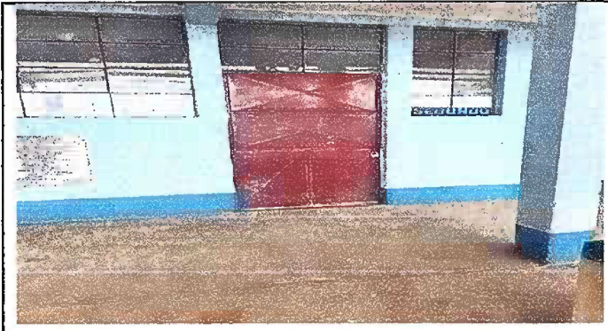
Foto 3, módulo 1: Sustrucción de chapa
