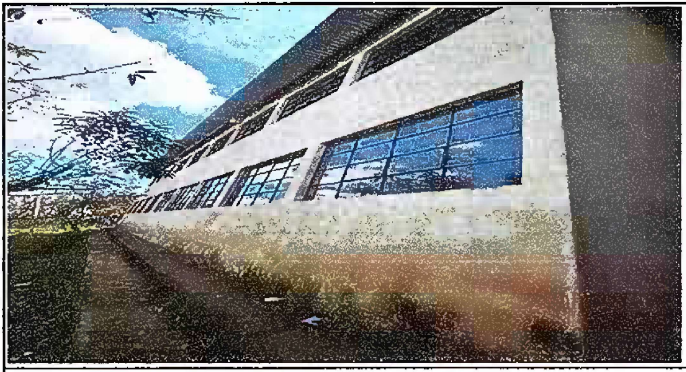
Foto 5, módulo 1: Pintura en muros exteriores e interiores
