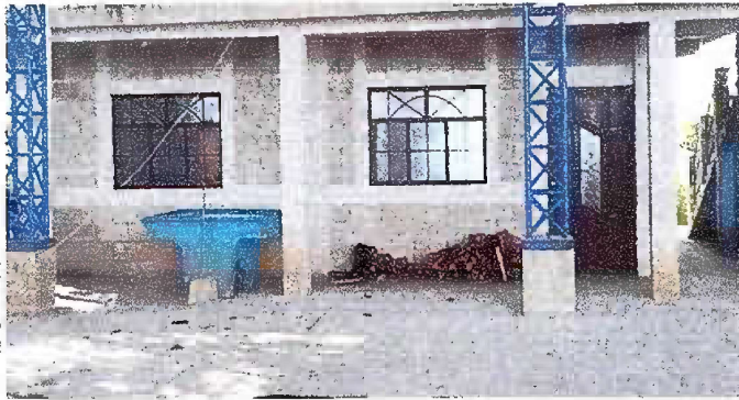
Foto 7, módulo 2: Suministro e instalación de balcón de metal.
