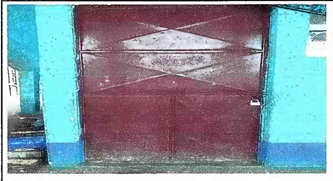
Foto 4, módulo 1: Mantenimiento a estructura de puerta (lijado, cepillado y aplicación de pintura)
