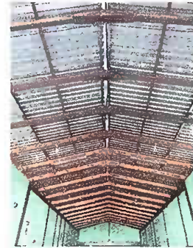
Foto 4: Modulo 1. Sustitución de capote para lámina troquelada
