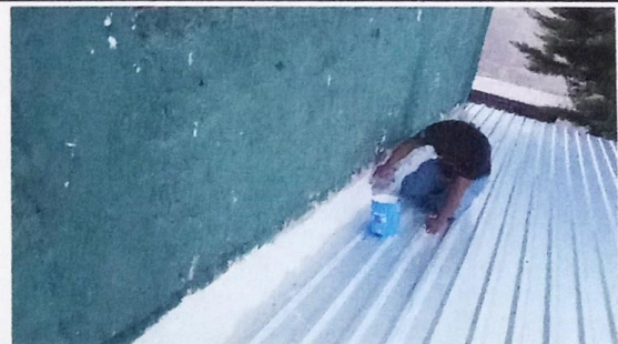
Foto 6: Modulo 1: Sustitución de pescantes
