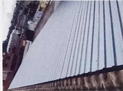
Foto 4: Modulo 1: Sustitución de capote para lamina troquelada
