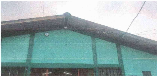
Foto 3: Modulo 1. Sustitución de elementos de fijación (tornillos), instalación de lámina aluzinc
