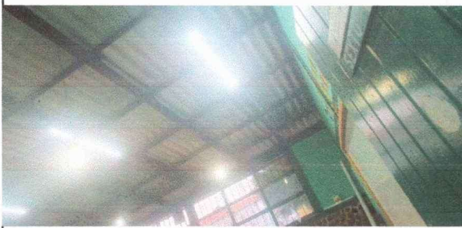
Foto 1: Modulo 1. Desinstalación e instalación del sistema electrico existente
