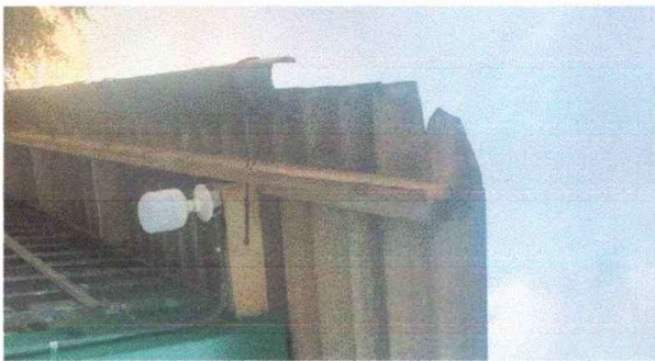
Foto 5: Modulo 1. Sustitución de canal de metal, sustitución de agua puvial, tubo pvc 3"
