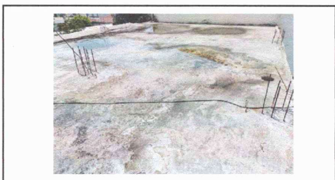
Módulo 2: Impermeabilización de losa.
