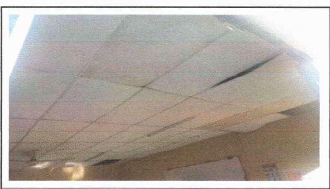
Módulo 1: Sustitución de cielo falso
