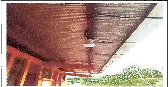
Foto 4: MODULO 2 Y 3 SUSTITUCION DE FOCOS AHORRADORES
