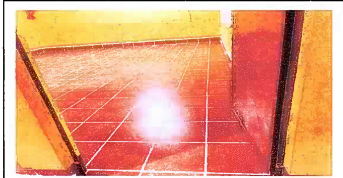
Foto 3: MODULO 3 SUSTITUCION DE PISO CONCRETO POR PISO CERAMICO
