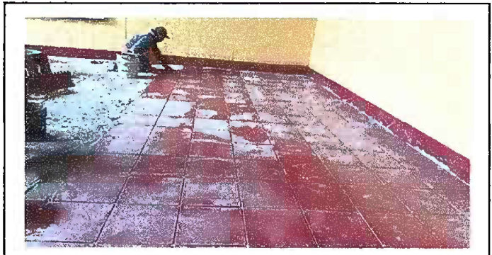
FOTO 6: MODULO 5 SUSTITUCION DE PISO CONCRETO POR PISO CERRAMICO
