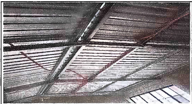
Foto 2: Módulo 1. sustitución de estructura metálica. Y levantado de mujinete.
