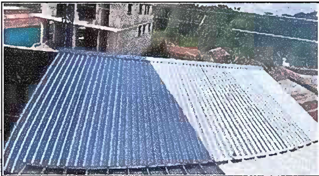
Foto7: Módulo 2. Sustitución de lámina troquelada.
