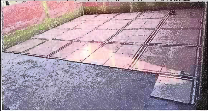
Foto7: Módulo 2. colocación de piso ceramico en el modulo 2.
