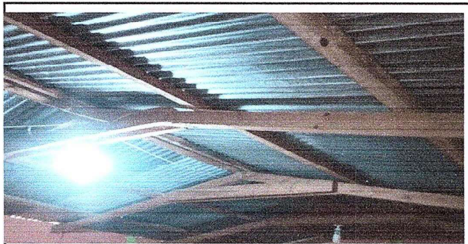
Foto 11: MODULO 2 Sustitución de estructura de soporte de madera por metal
