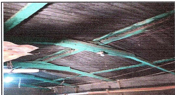
Foto 3: MODULO 1 Sustitución de cables
