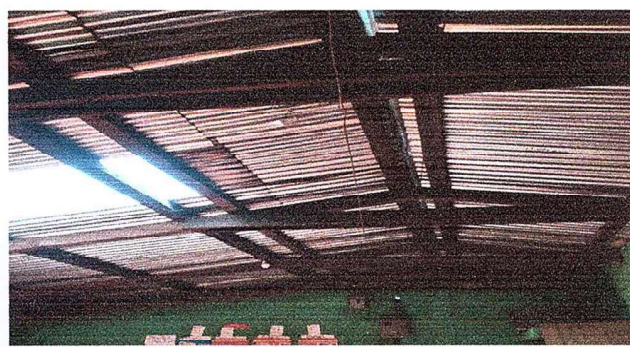
Foto 4: MODULO 1 Sustitución de estructura de soporte de madera por metal
