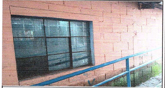
Foto 14: Sustitución de ventana de metal
