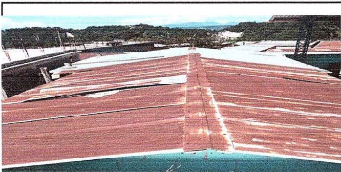
Foto1: MODULO 1 Sustitución de lámina, por lámina troquelada aluzinc calibre 26
