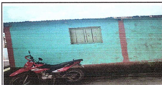
Foto 5: MODULO 1 Reparación de muro de block
