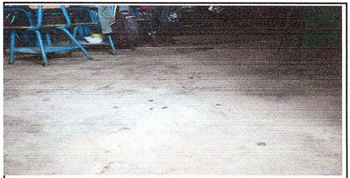
Foto 12: MODULO 2 Sustitución piso de concreto por piso cerámico
