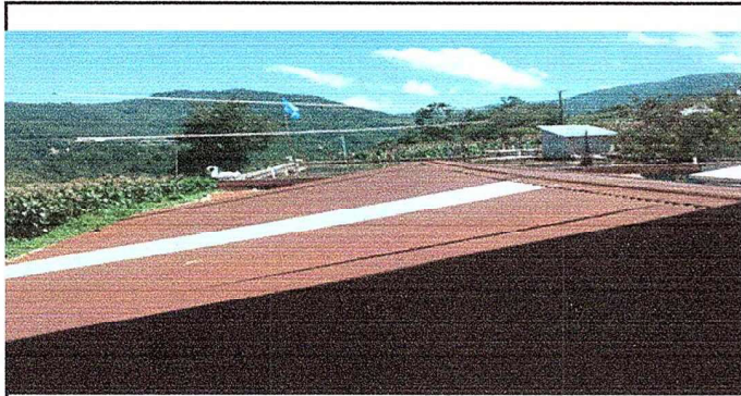
Foto 9: MODULO 2 Sustitución de láminas troqueladas
