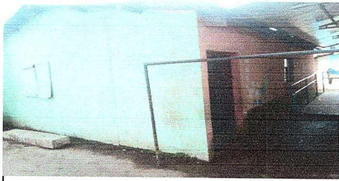
Foto 13: MODULO 2 Sustitución de puerta
