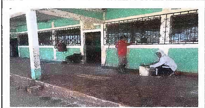
Foto 2: (MODULO 1). En esta área son los corredores de las tres aulas aun falta terminar la colocación de los zócalos.
