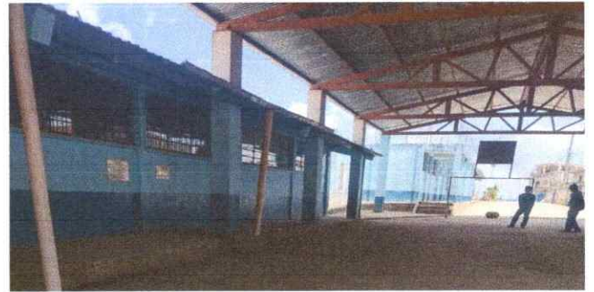
Foto 4: Sustitución de tubería de PVC de aguas pluviales
