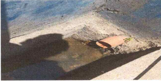
Foto 7: Sustrucción de tubería PVC línea principal aguas negras.
