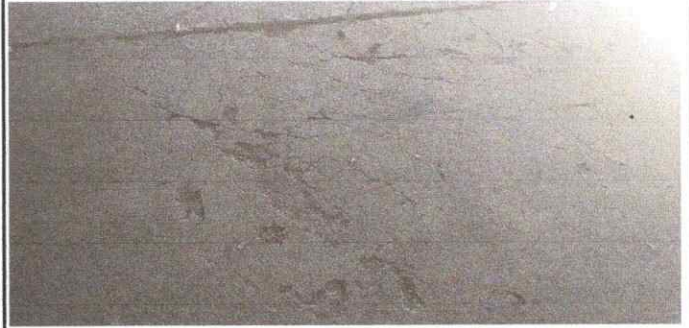
Foto 8: Reparación de plancha de concreto de patio
