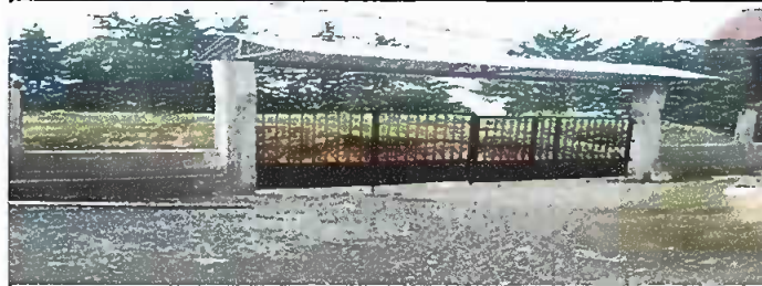
Foto 3: COLOCACIÓN DE PORTON
