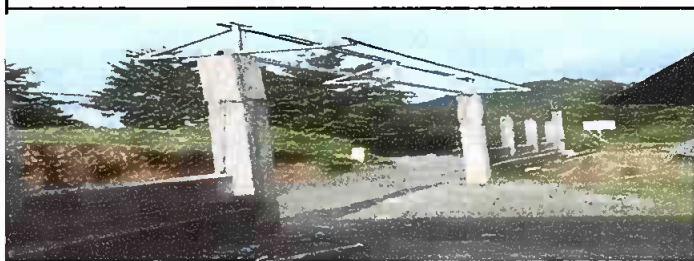
Foto 3: COLOCACIÓN DE LAS VIGAS DE PORTON
