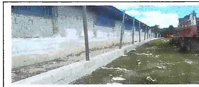
Foto 2: COLOCACIÓN DE TUBO DE METAL
