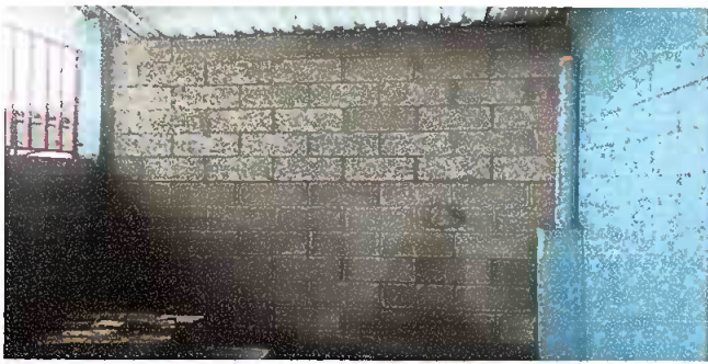
Foto 1: MODULO 1 Reparación de muro de block
