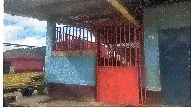
Foto 2: MODULO 1 Suministro e instalación de ventanas tipo rejilla
