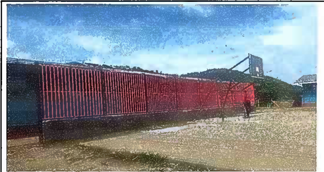
Foto 4: CANCHA: Suministro e instalación de columna y barranda de metal sobre muro
