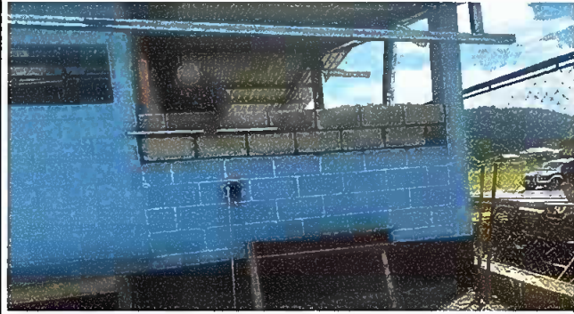
Foto 1: MODULO 1 Reparación de muro de block
