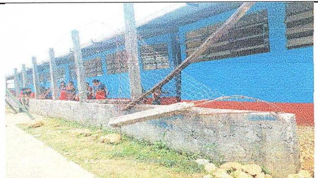
Foto 6: CANCHA: Suministro e instalación de barranta de metal sobre muro
