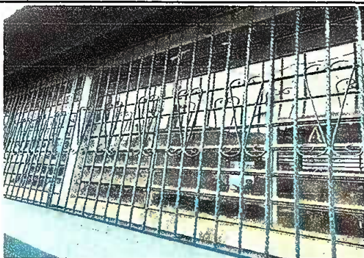
Foto 3: MODULO1, SUMINISTRO E INSTALACIÓN DE BALCONES
