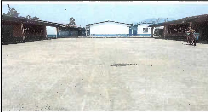
Foto1: PINTURA GENERAL: PINTURA EN MUROS INTERIOR Y EXTERIOR
