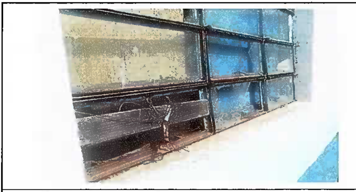
Foto 5: MODULO 4, SUSTITUCIÓN DE VIDRIOS
