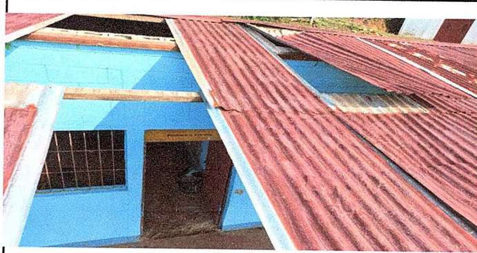
Foto 1: MODULO 1; Sustitución de laminas, por laminas troqueladas aluzinc calibre 26
