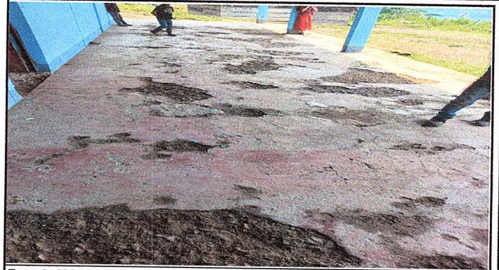
Foto 2: MODULO 1; Reparación de piso de torta de concreto por piso ceramico
