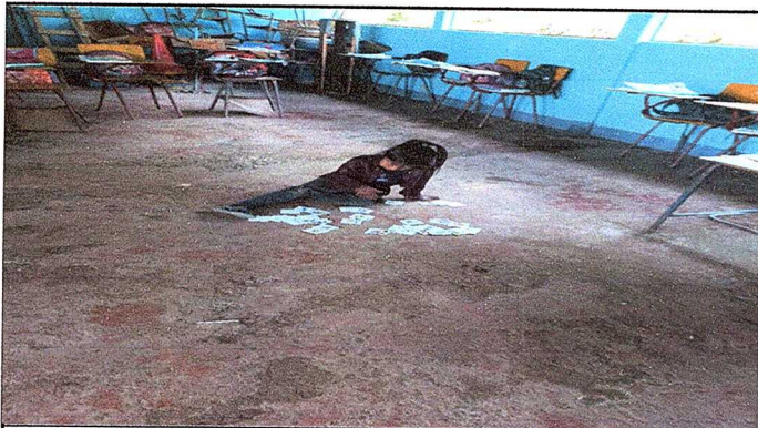
Foto 3: MODULO 1; Reparación de piso de torta de concreto por piso ceramico
