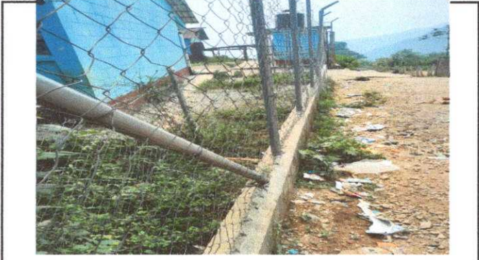
FOTO 1: Muro perimetral, reparación de muro perimetral de block con block con tubo hg y malla galvanizada, soleras intermedias y columnas
