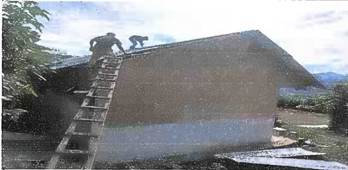
SUSTITUCION DE LAMINA TROQUEDADA
