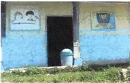
Foto 3: SUSTITUCION DE UNA PUERTA
