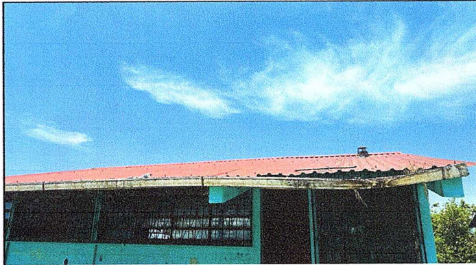
Foto 1: MODULO 1 sustitucion de puerta y sustitucion de canal de pvc
