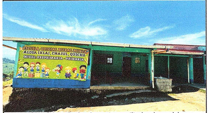
Foto 2: MODULO 2 sustitucion de puertas, sustitucion de canal de pvc, reparacion de bajada pluvial, tubo pvc 3" Y sustitucion de pila.
