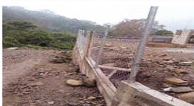
FOTO 2 SUSTITUCION DE ALAMBRE Y TUBO GALVANIZA DE LA CIRCULACION
