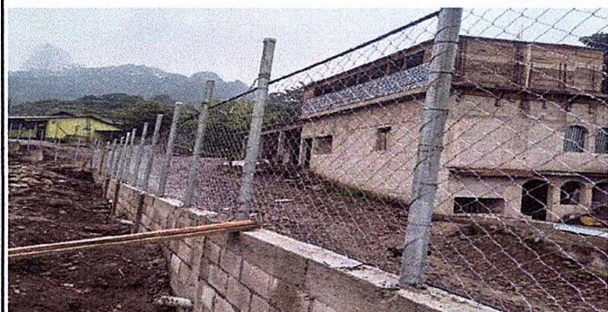
FOTO 1 SUSTITUCION DE MAYA PARA LA CIRCULACION
