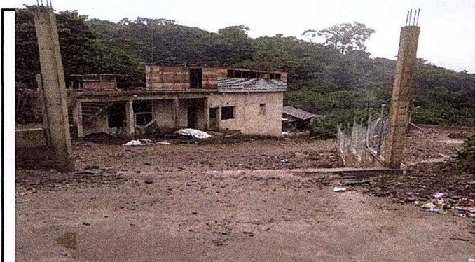
foto 3 SUSTITUCION DE CULUMNAS DEL PORTON
