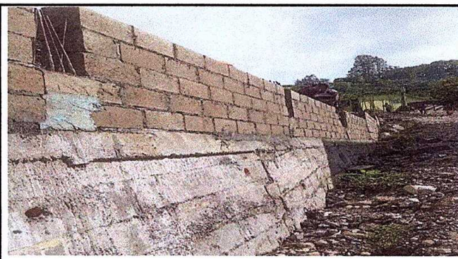
FOTO 4 SUSTITUCION DE MURO PARA LA CIRCULACION
