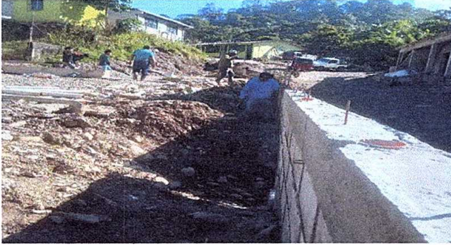
FOTO 1 MODULO 1 SUSTITUCION DE MURO PERIMETRAL
