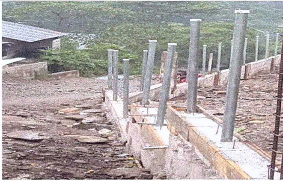
FOTO 3 SUSTITUCION DE TUVOS GALVANIZADA
