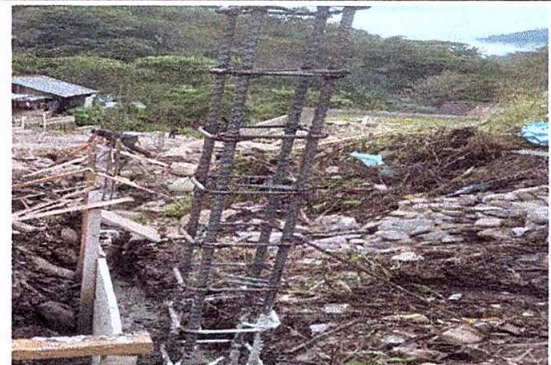
FOTO 4. CONSTRUCCION DE COLUMNAS
