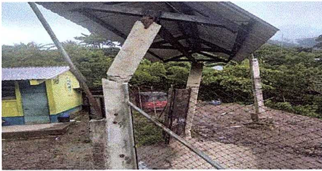
FOTO 3 SUSTITUCION DE COLUMNA DEL PORTON
