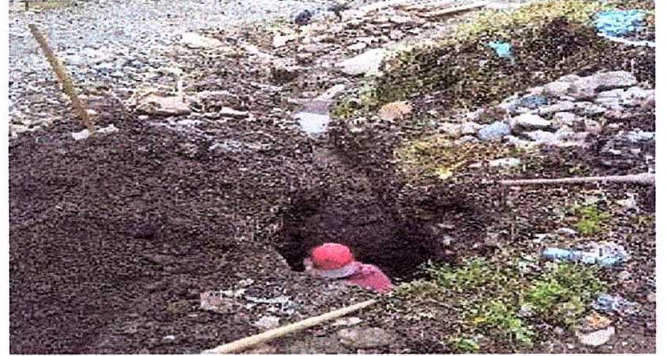
FOTO. 2 SUSTITUCION DE MURO
