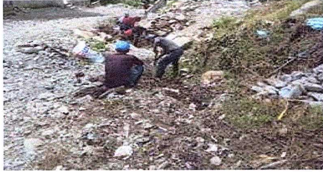
FOTO 1 SUSTITUCION DE CIRCULACION
