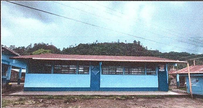
Foto 9 MODULO 3: SUSTITUCIÓN DE LAMINAS, POR LAMINA TROQUELADA ALUZINC CALIBRE 26
