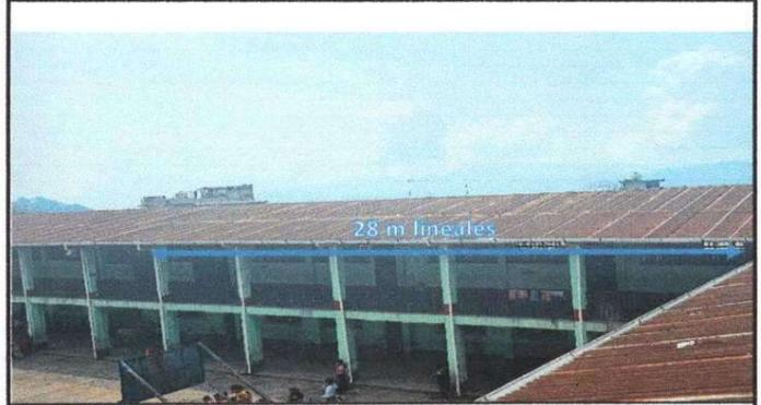
**MODULO II. Sustitución de lámina, por lámina troquelada aluzinc calibre 26 +capotes + elementos de fijación/tornillos = 294 m2**
