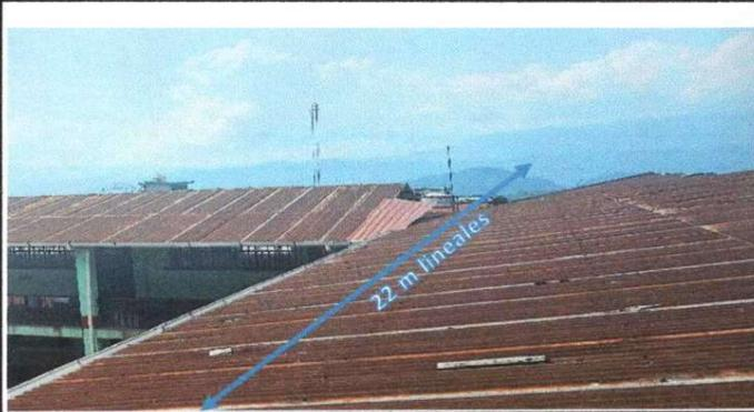
**MODULO I. Sustitución de lámina, por lámina troquelada aluzinc calibre 26 +capotes + elementos de fijación/tornillos= 232 m2.**
