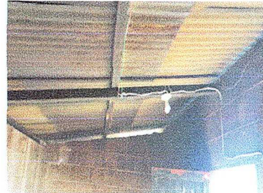
FOTO 2 MODULO I: SUSTITUCION DE ESTRUCTURA PORTANTE DE MADERA POR METAL
