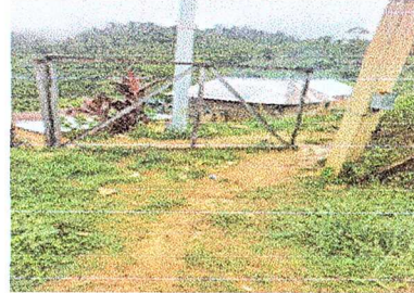
FOTO 8 AREAS EXTERIORES: SUSTITUCION DE PORTON
