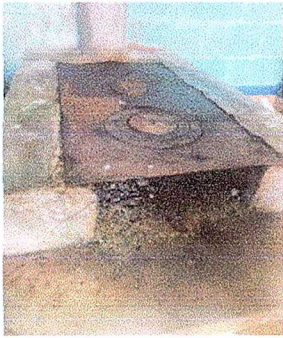
FOTO 3 MODULO I: SUSTITUCION DE PLANCHA DE METAL Y CHIMENEA DE CONCRETO
