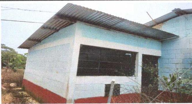
Foto 3: MODULO 2 SUSTITUCIÓN DE LAMINA
