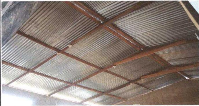
Foto 1: MODULO 1, SUSTITUCIÓN DEL ESTRUCTURA CON ESTRUCTURA METÁLICA.
