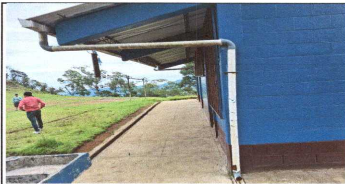
FOTO 3, MODULO 1, SUSTITUCIÓN DE CANALES Y BAJADAS DE AGUA
