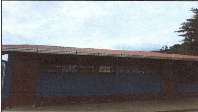
FOTO 1, MODULO 1, SUSTITUCION DE LAMINAS TROQUELADAS
