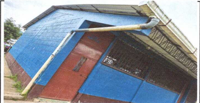
FOTO 2, MODULO 1, SUSTITUCION DE CANALES Y BAJADAS DE AGUA
