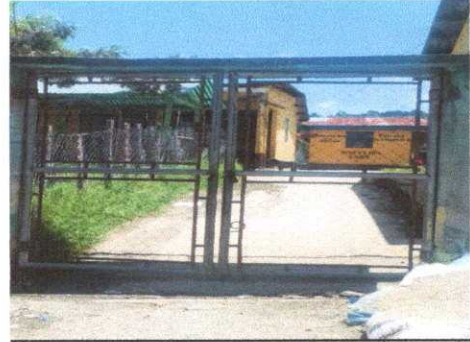
Foto 2: sustitucion de porton Metal
