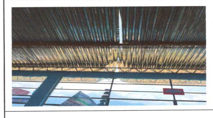
Foto 6: MODULO 1. Sustitucion de laminas, por lamina troquelada aluzinc calibre 26
