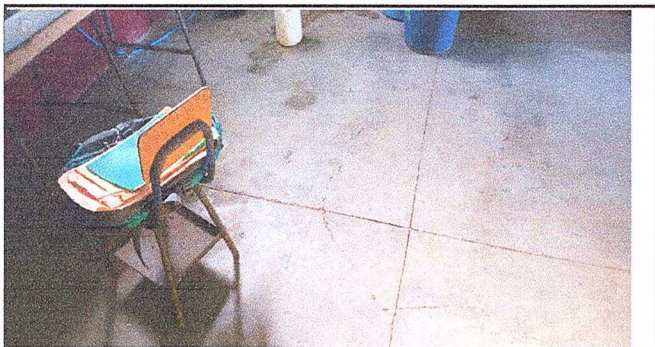
FOTO 5: MODULO 1 SUSTITUCION DE PISO DE CONCRETO AULA 2 A CERAMICO
