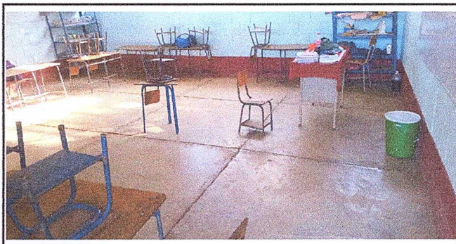
FOTO 6: MODULO 1 SUSTITUCION DE PISO DE CONCRETO DE AULA 3 A CERAMICO
