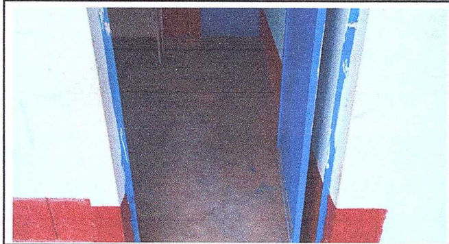
FOTO 1: MODULO 1 SUSTITUCION DE PISO DE CONCRETO A CERAMICO
