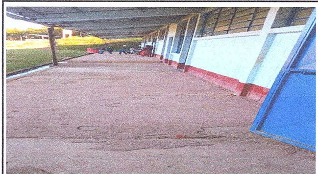
FOTO 2: MODULO 1 SUSTITUCION DE PISO DE CONCRETO EN PATIO A CERAMICO
