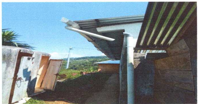
Foto 4: MODULO 1 REPARACIÓN DE BAJADA DE AGUA
