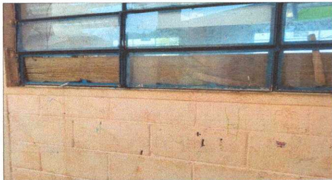
Foto 3: MODULO 1 SUSTITUCION DE VÍDRIOS EN VENTANAS
