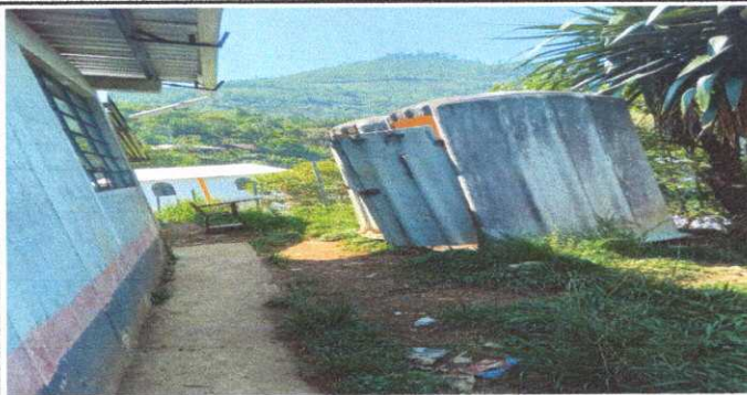
Foto 5: MODULO 2 SUSTITUCION DE INODORO
